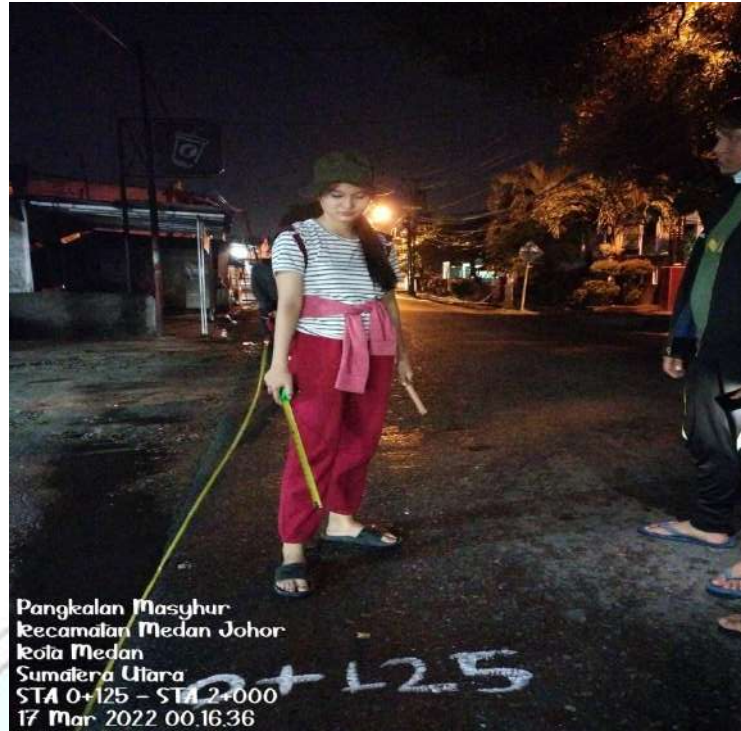
Foto pada saat menandai setiap STA
